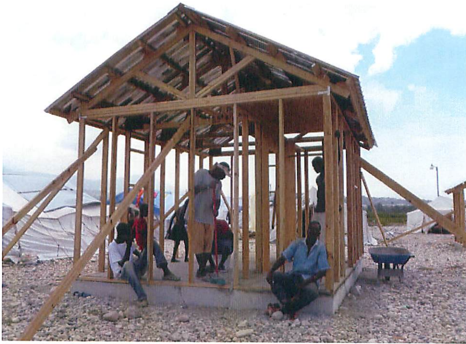
建設中の仮設住宅
